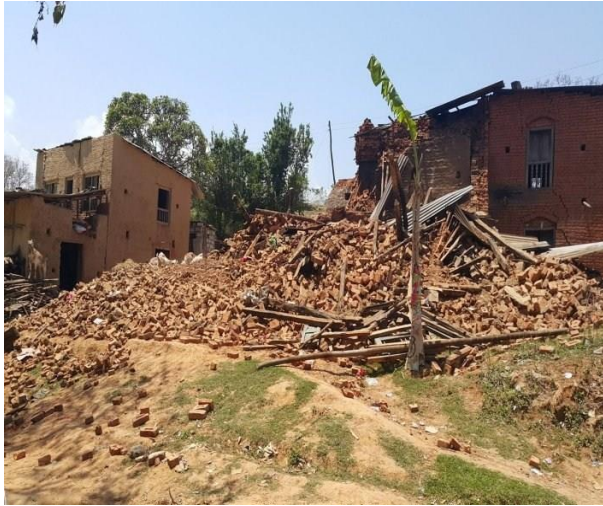
地震で全壊した家
